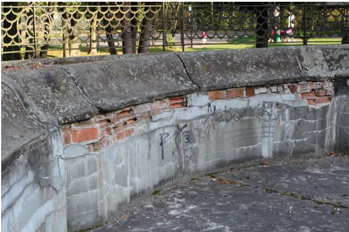
2. Stan zachowania ścianek obwodowych – bortnicy fontanny.
