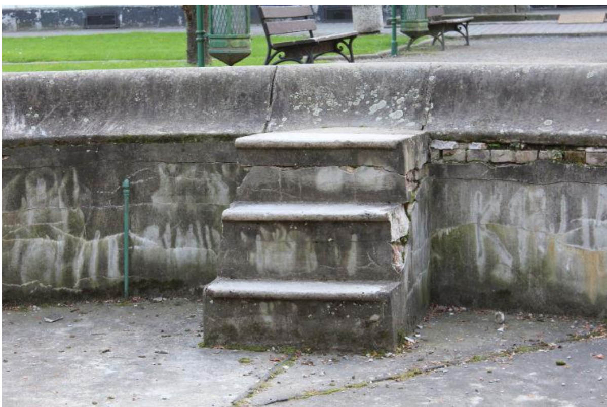
4. Schodki i rura zasilająca zbiornik w wodę.
