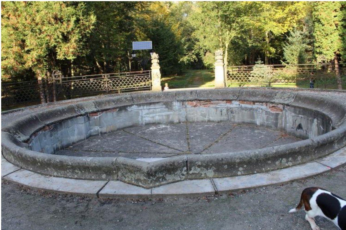
1. Widok zbiornika - widoczny podział ścianek na murowany dół i kamienne zwieńczenie.
