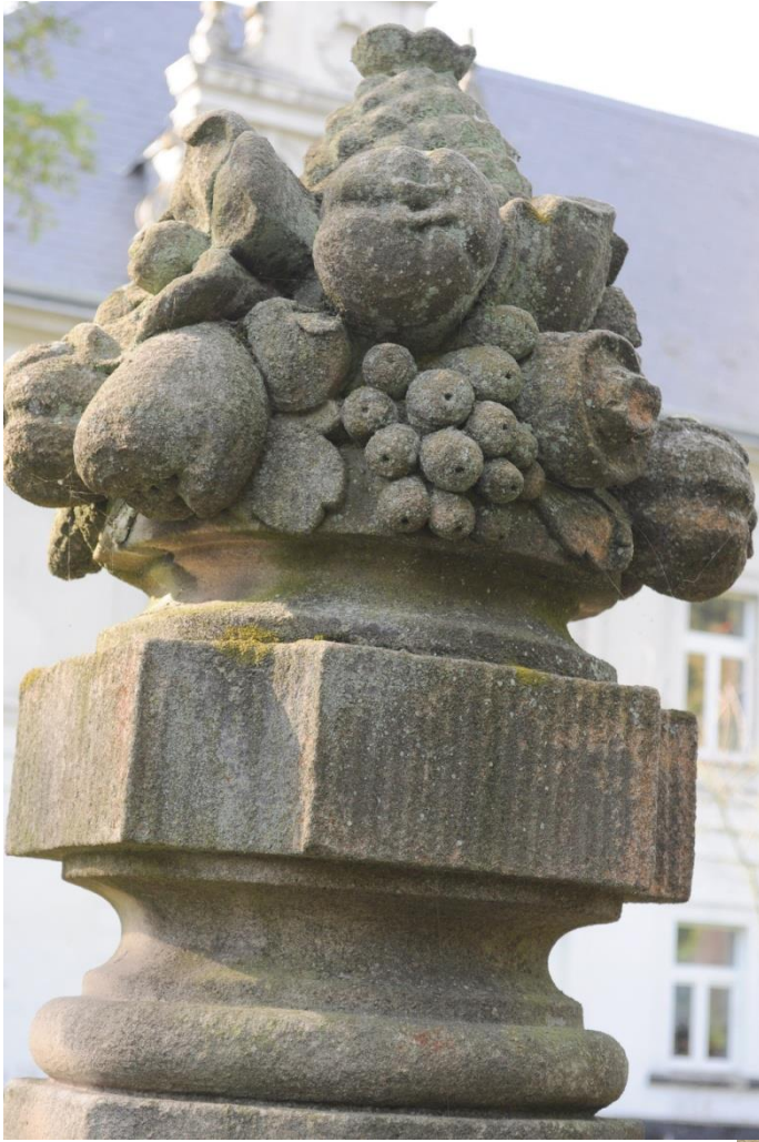
Fragment cokołu balustrady z dekoracją rzeźbiarską.
